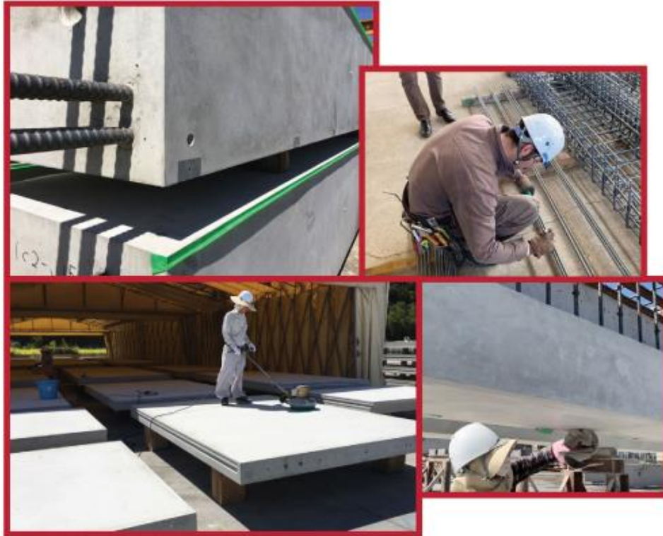
Polimento e limpeza de lajes pré-moldadas de concreto. Tanta confiança.
