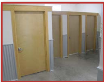
Compartimentos na casa de banho completamente privados
